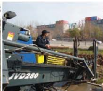
湖南郴州施工现场 Jobsite in Chenzhou Hunan
